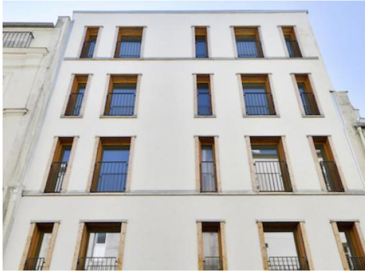
Gebäude aus Hanfkalk in Paris
